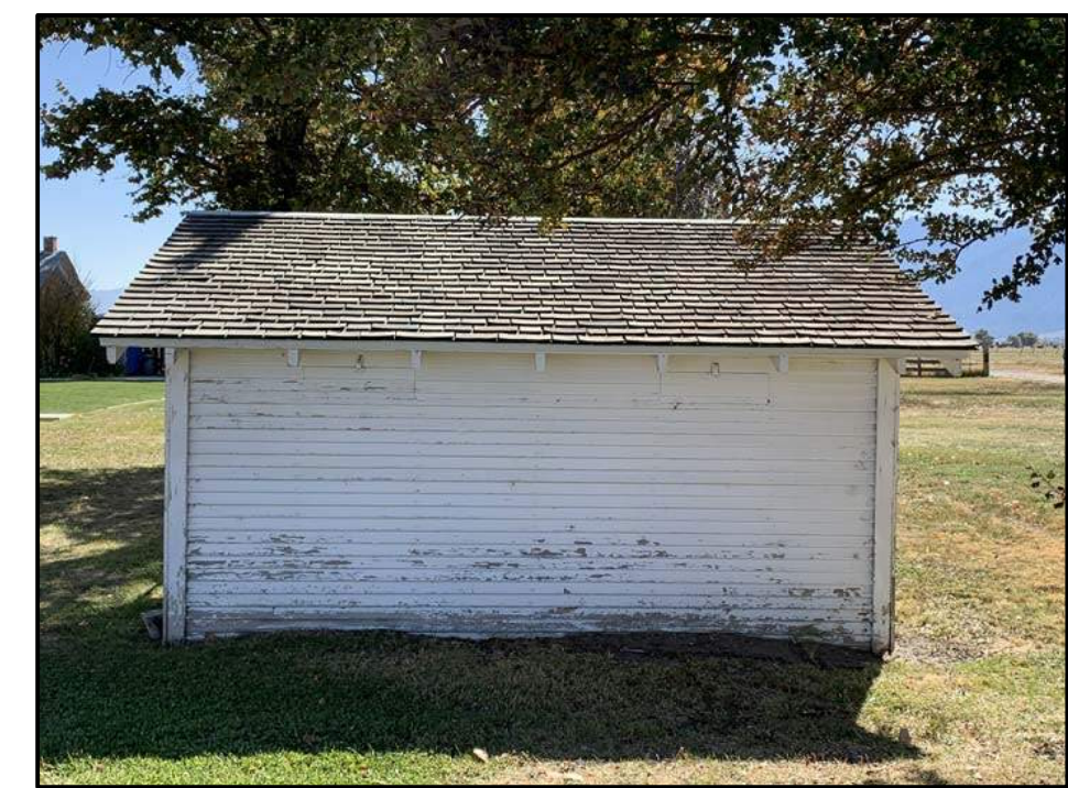
B2 Dog House - Exterior Photo North Elevation N. T. S.
