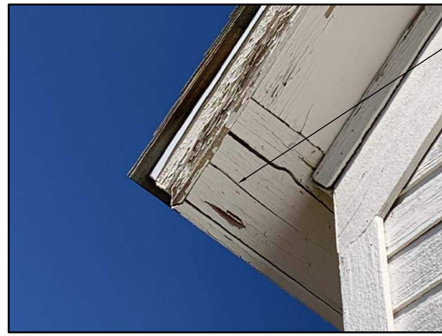
A5 Photo of Existing Condition N.T.S.
