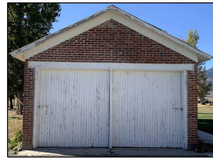
B3 Garage - Exterior Photo East Elevation N. T. S.
