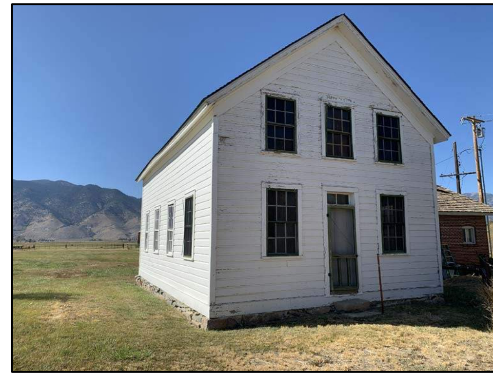
A3 Bunk House - Exterior Photo Northeast Elevation N. T. S.
