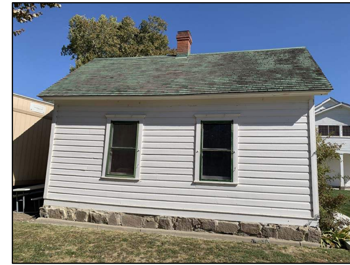
B3 Laundry House - Exterior Photo West Elevation N. T. S.
