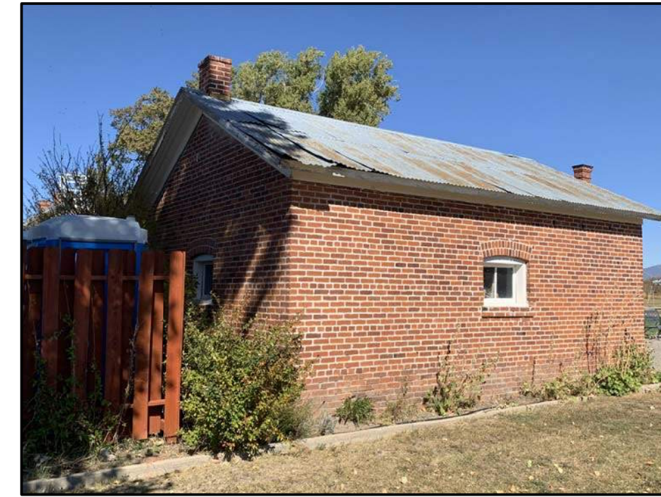
A3 Garage - Exterior Photo South West Elevation N. T. S.
