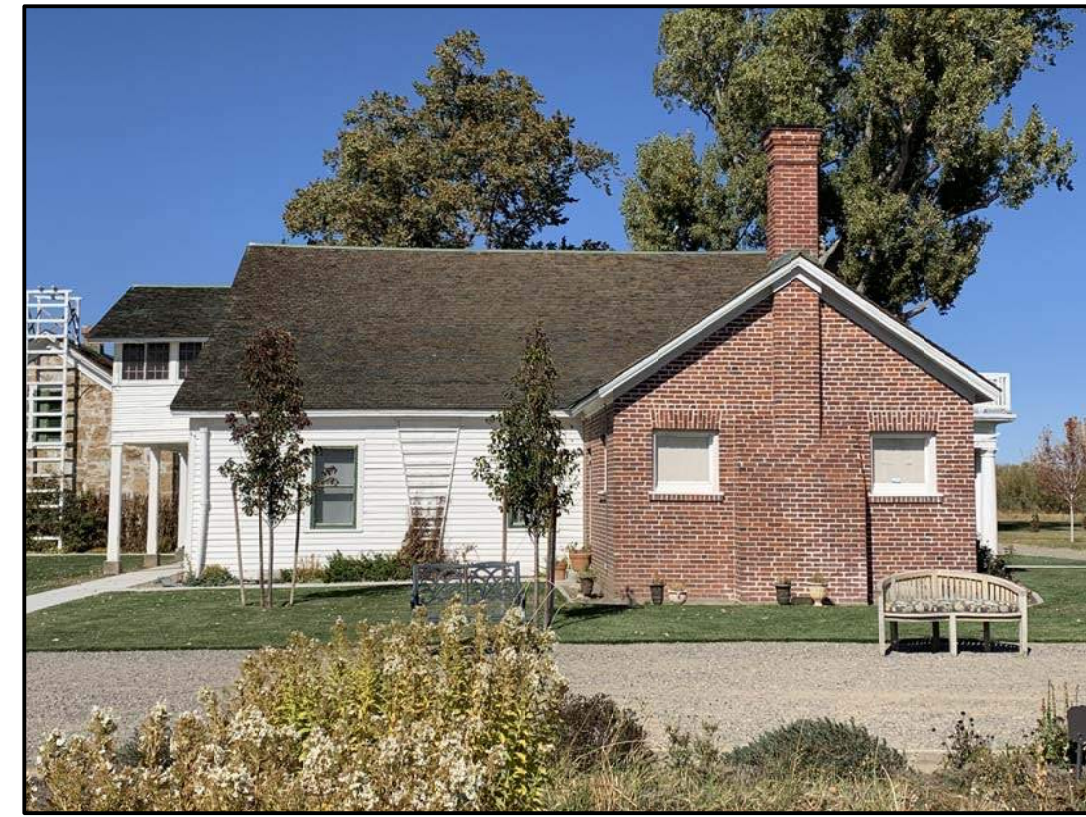
A3 Main House - Exterior Photo South Elevation N. T. S.
