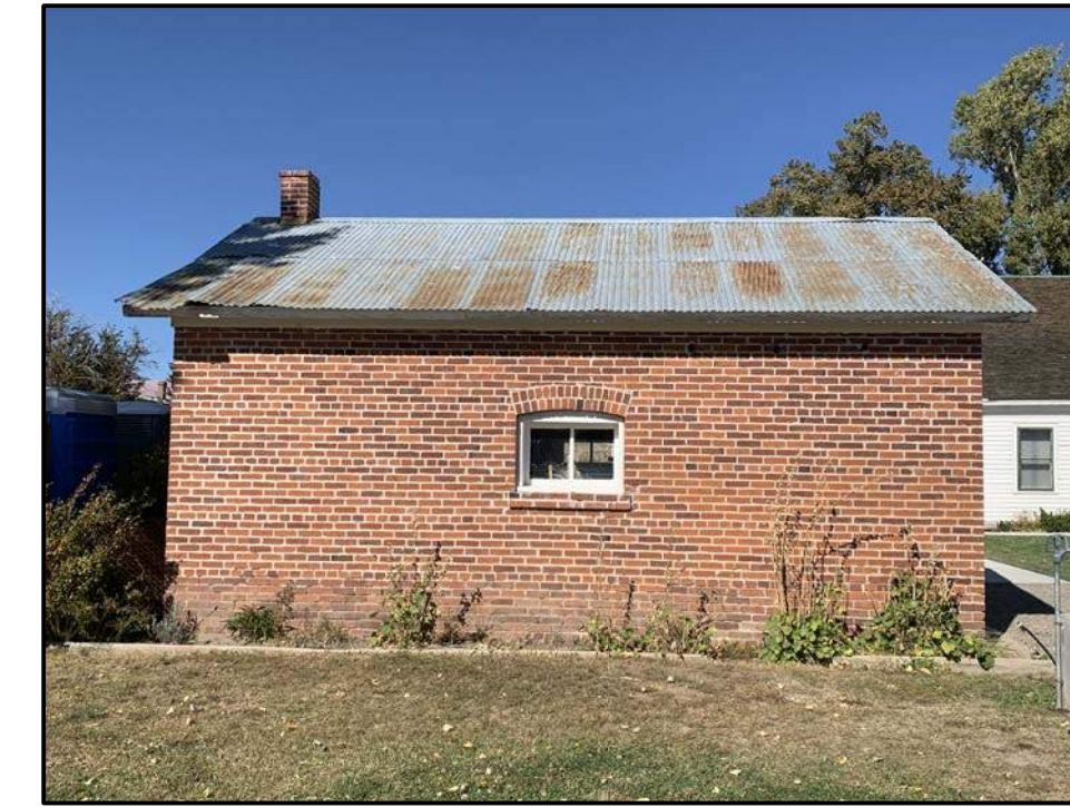
A2 Garage - Exterior Photo South Elevation N. T. S.
