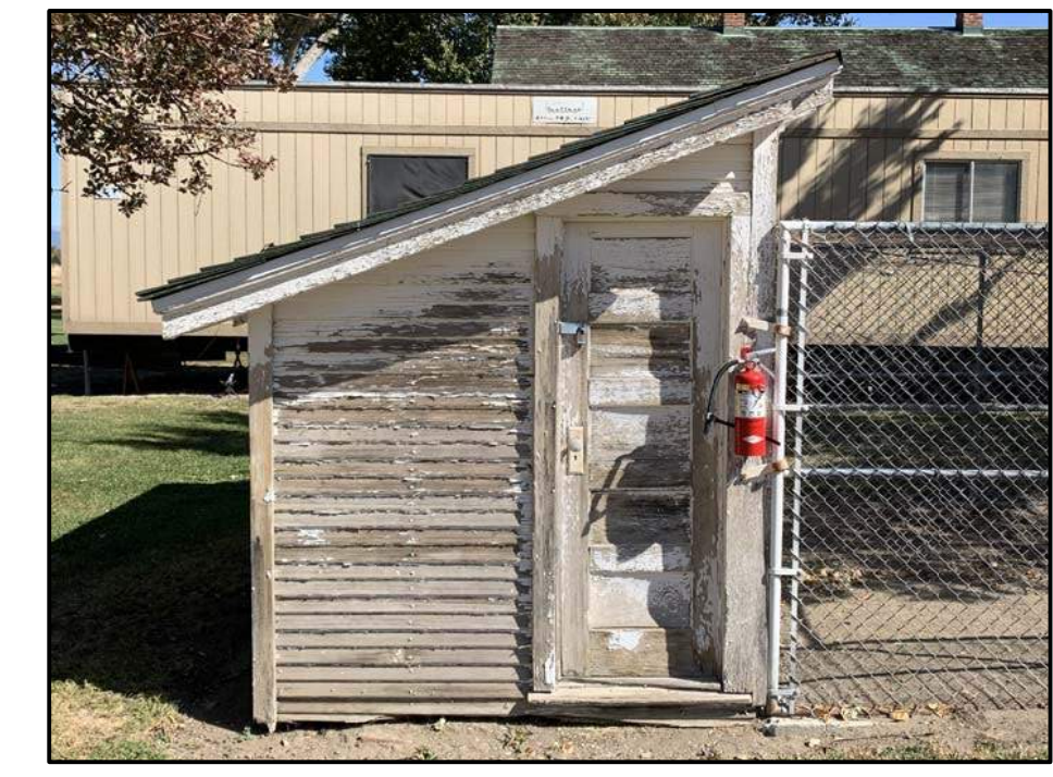
C3 Dog House - Exterior Photo West Elevation N. T. S.
