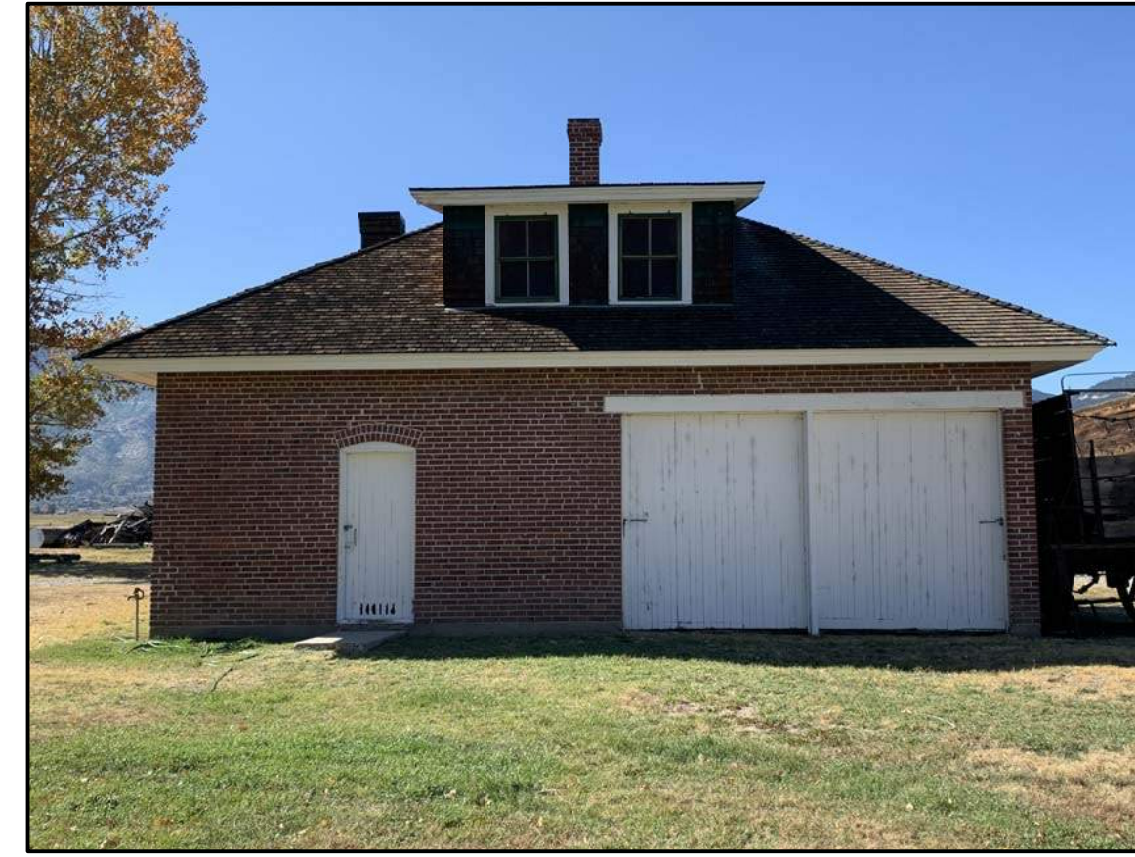
B3 Carriage House - Exterior Photo East Elevation N. T. S.
