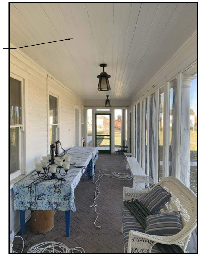
D1 Photo of Existing Condition N.T.S.
