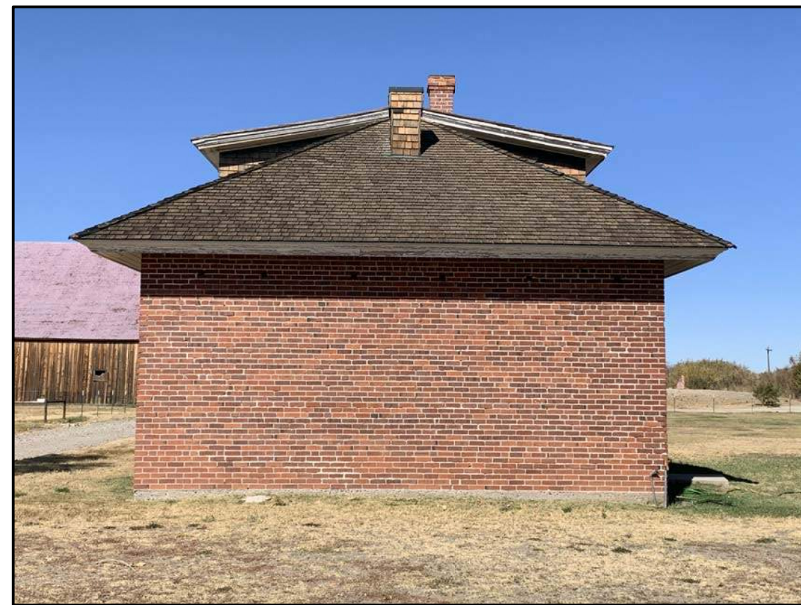
B4 Carriage House - Exterior Photo South Elevation N. T. S.
