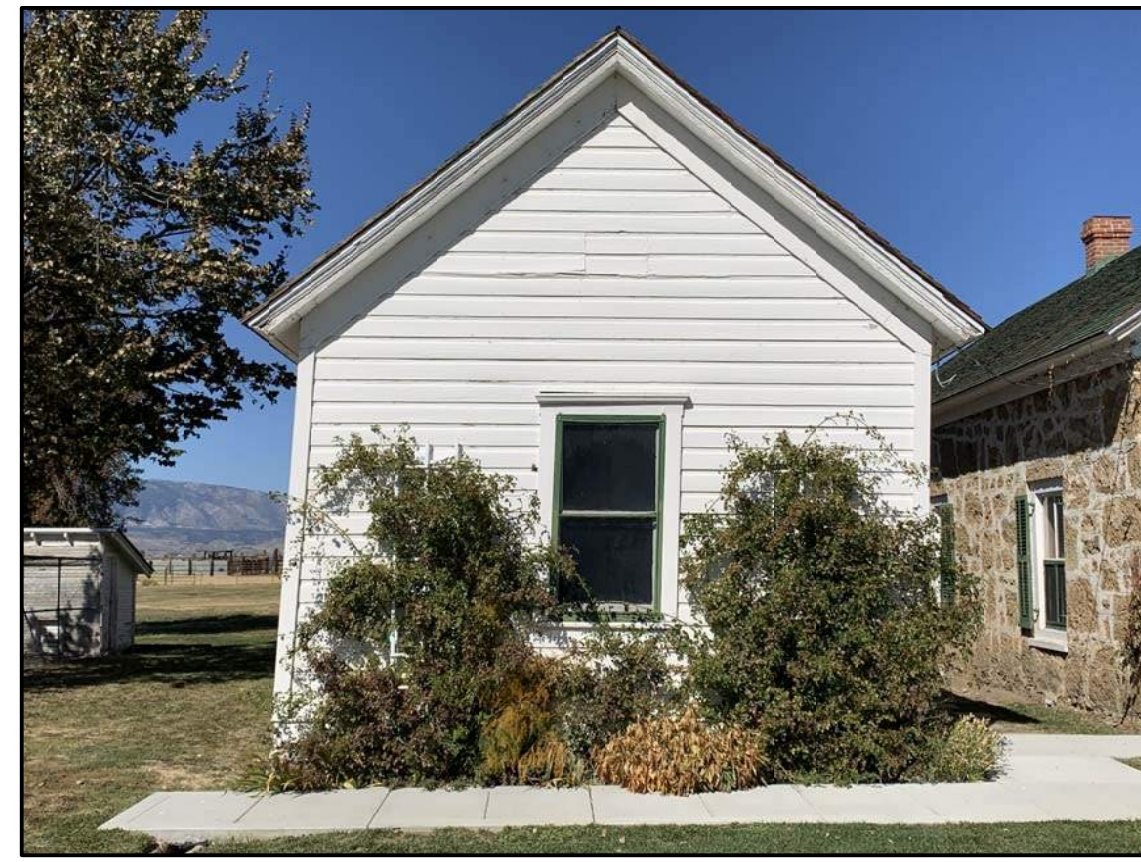
A4 Laundry House - Exterior Photo North Elevation N. T. S.
