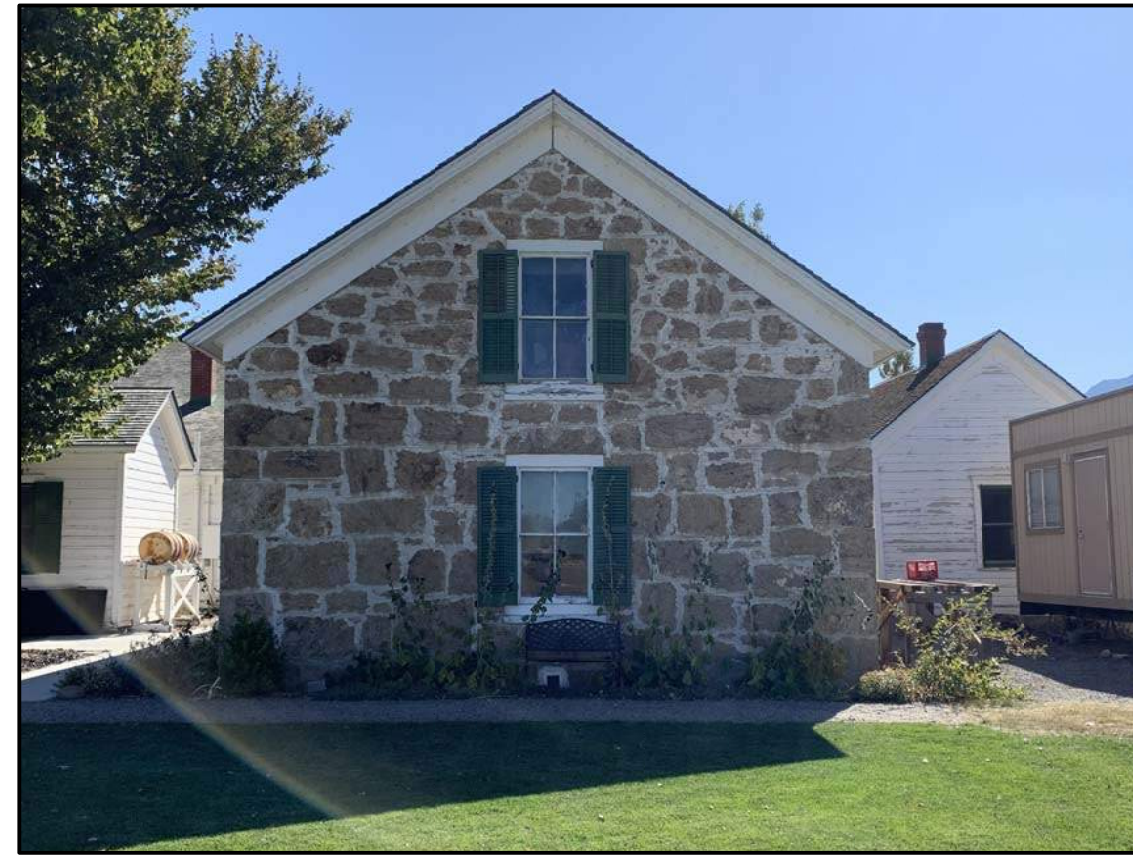
A4 Stone Cellar - Exterior Photo North Elevation N. T. S.
