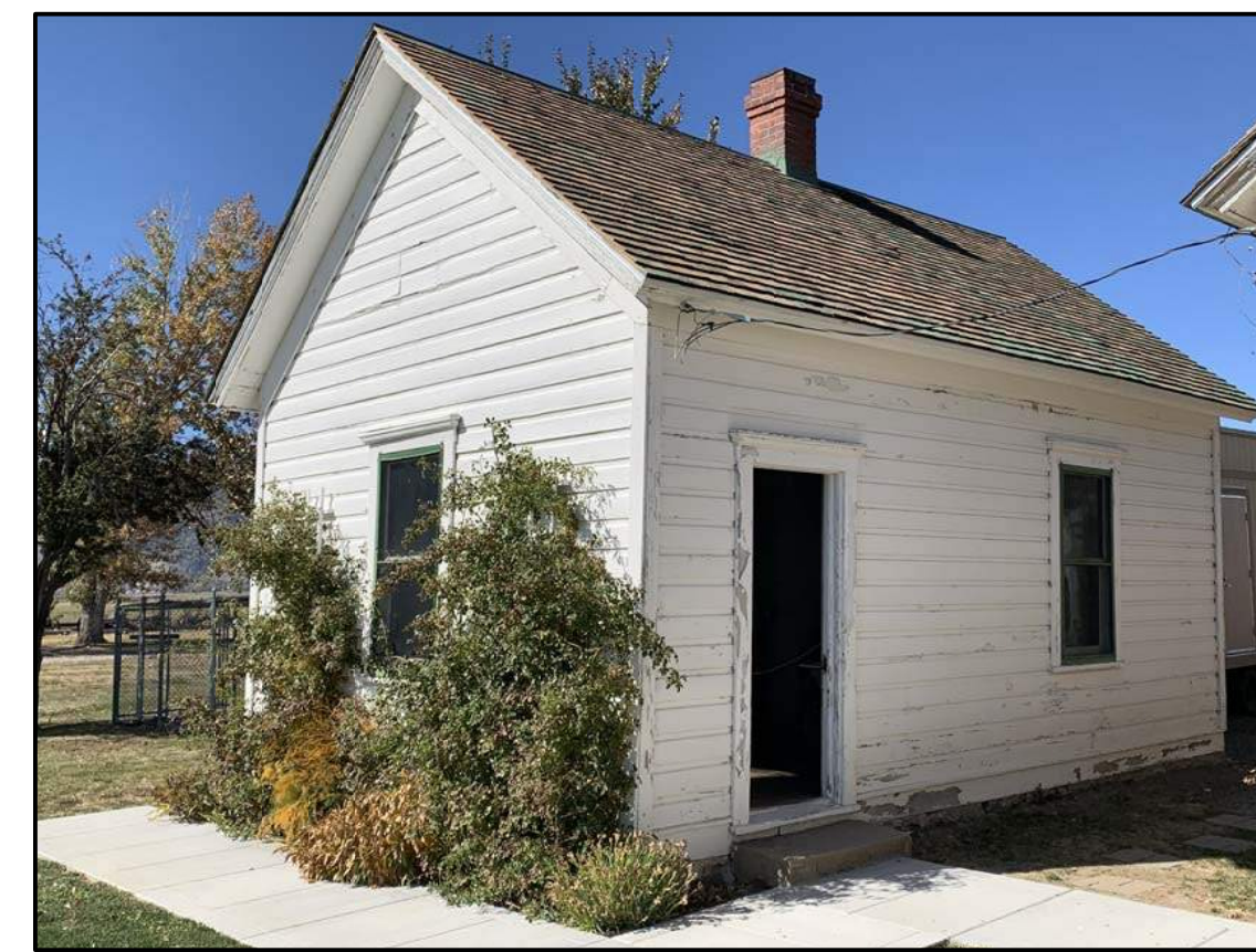
A3 Laundry House - Exterior Photo Northeast Elevation N. T. S.
