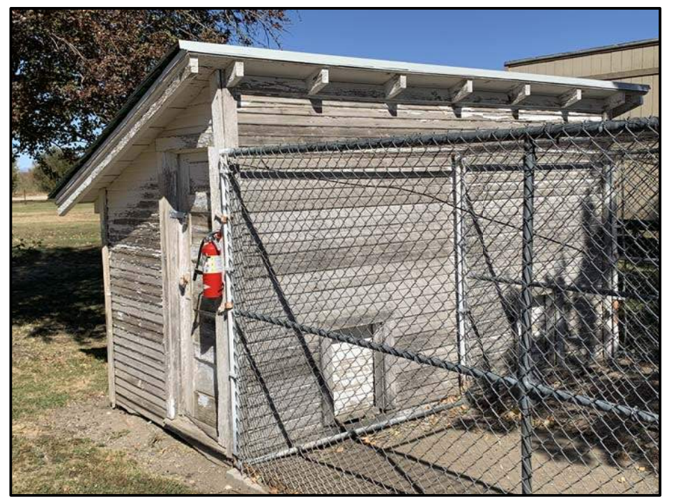
C2 Dog House - Exterior Photo South Elevation N. T. S.
