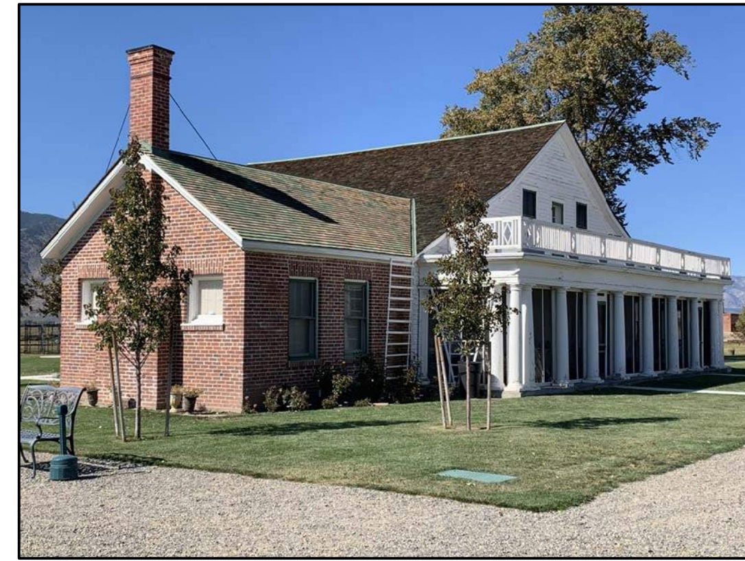
A2 Main House - Exterior Photo Southeast Elevation N. T. S.
