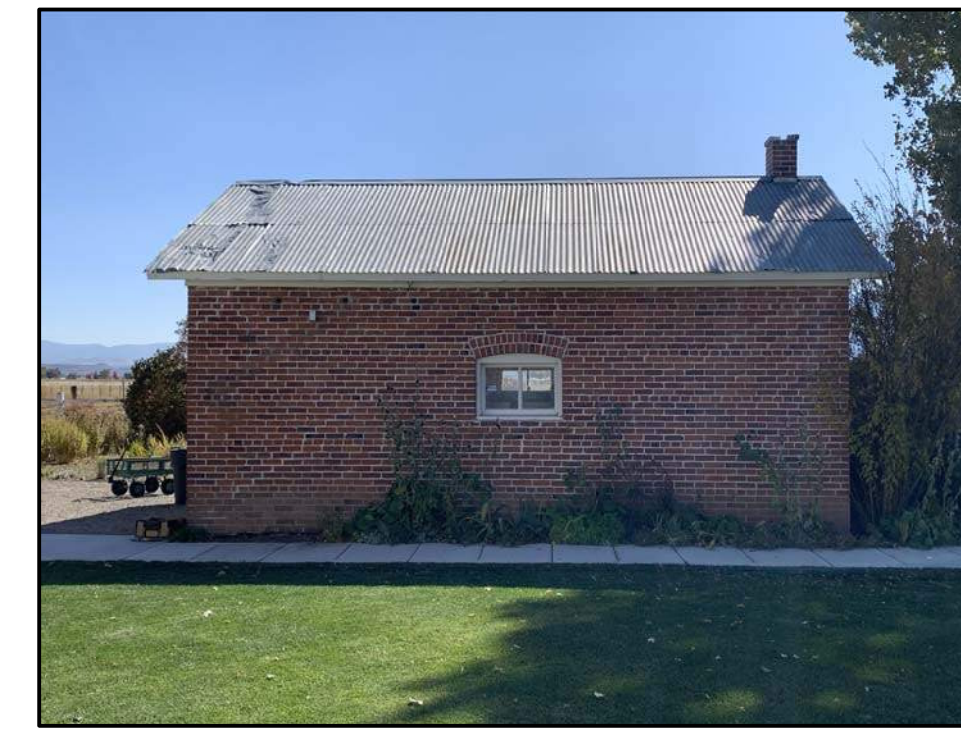
B2 Garage - Exterior Photo North Elevation N. T. S.
