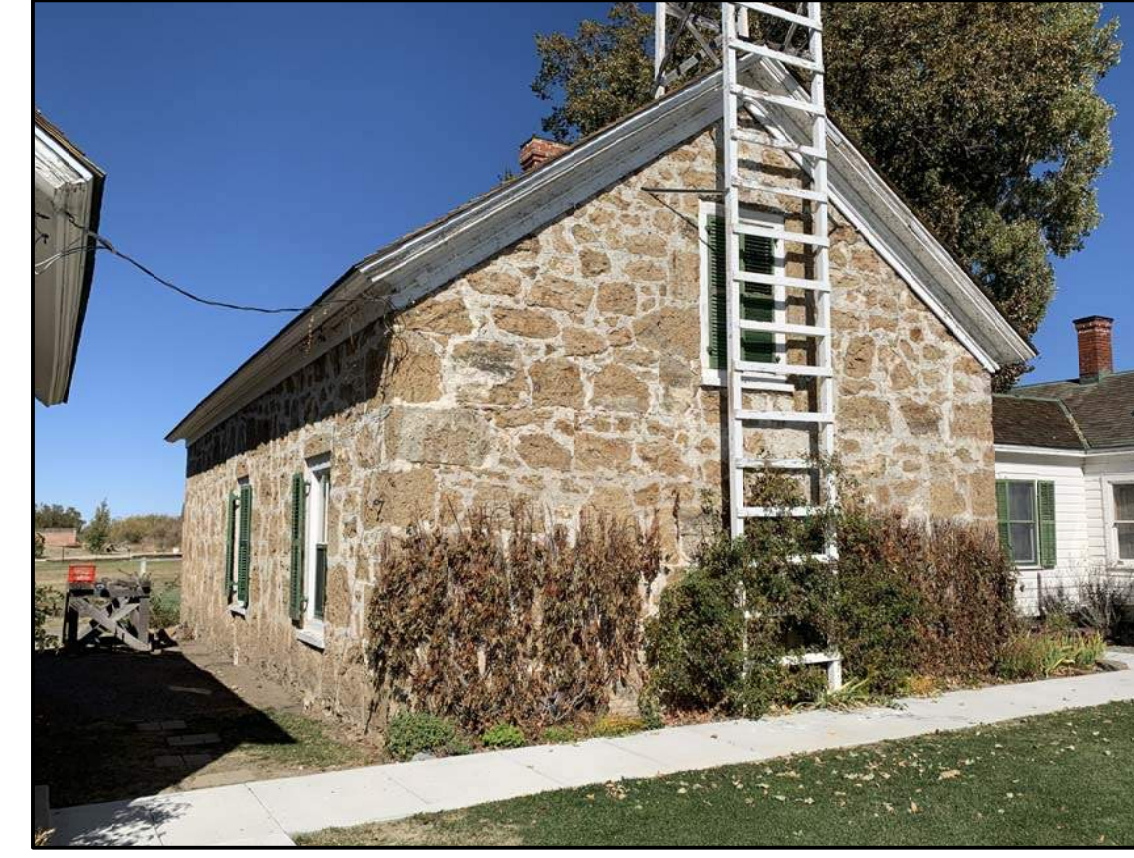
A3 Stone Cellar - Exterior Photo Southwest Elevation N. T. S.
