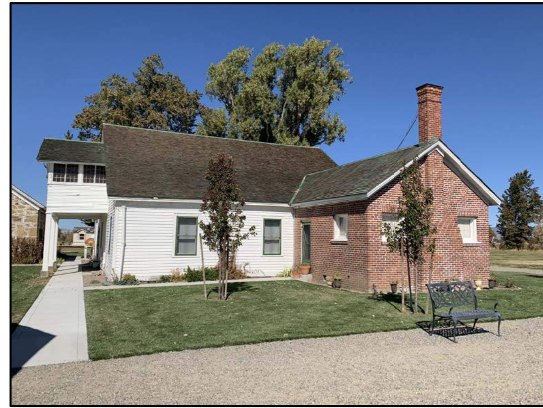
A4 Main House - Exterior Photo Southwest Elevation N. T. S.
