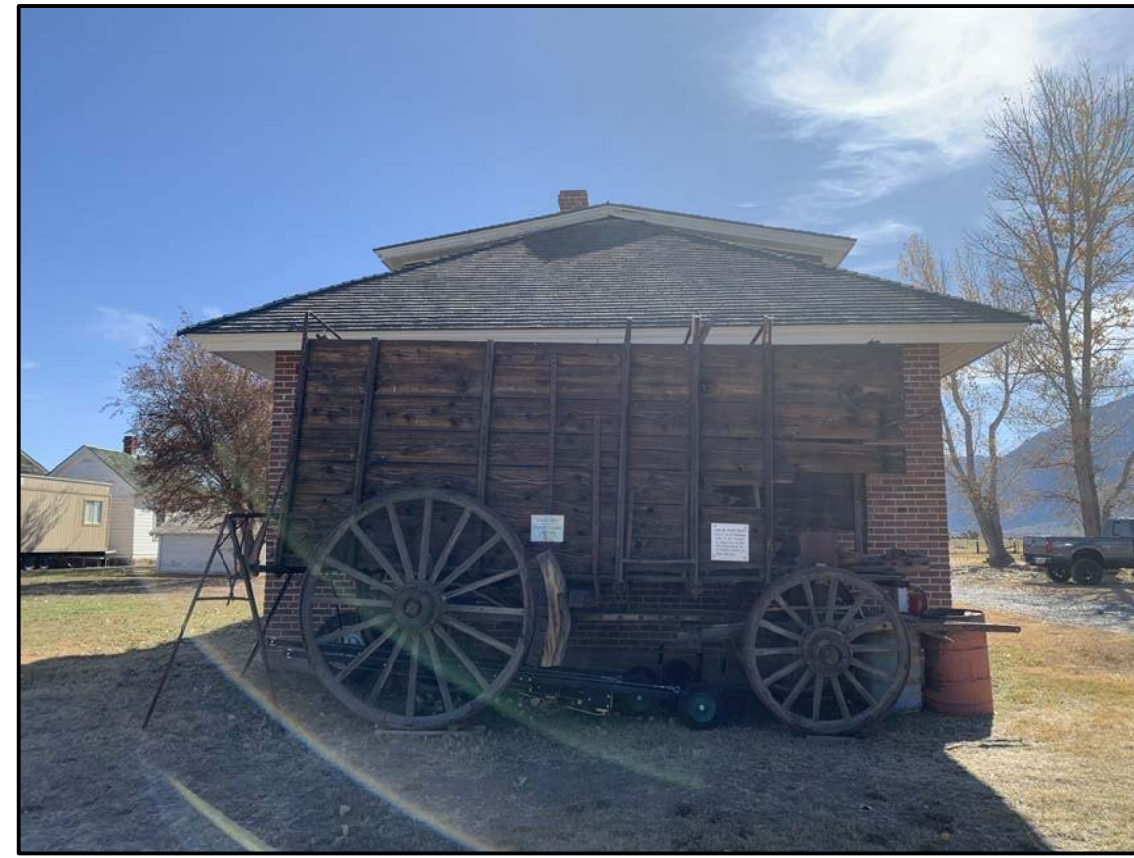
A4 Carriage House - Exterior Photo North Elevation N. T. S.
