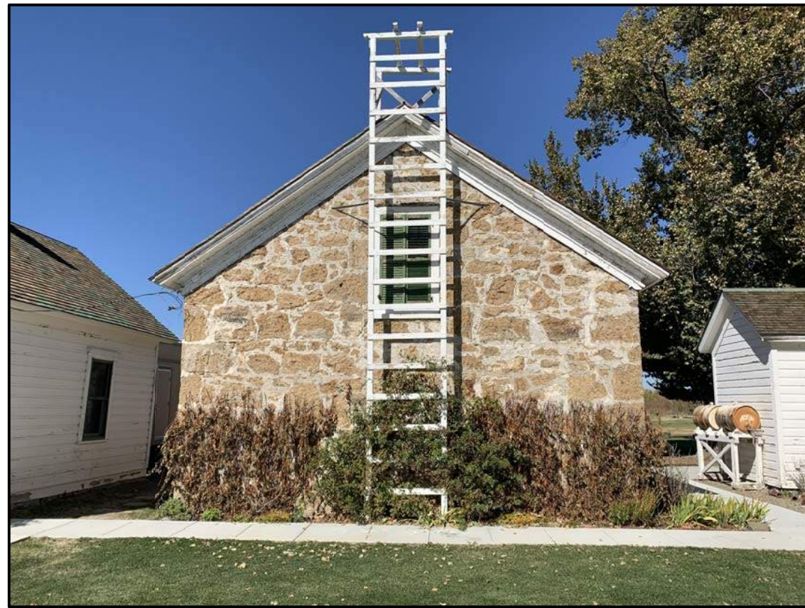
B4 Stone Cellar - Exterior Photo South Elevation N. T. S.
